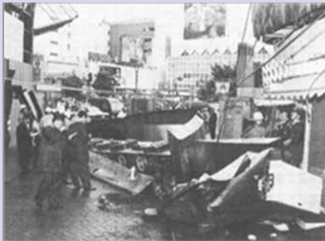
台風で落下した時の様子
